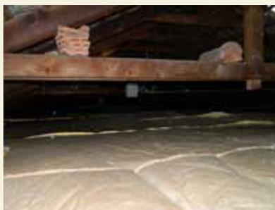
Nel sottotetto della Scuola Primaria è stato posato un consistente strato di lana di roccia, che consentirà un miglior isolamento termico dello stabile, con benefici effetti sulle spese per il riscaldamento.
