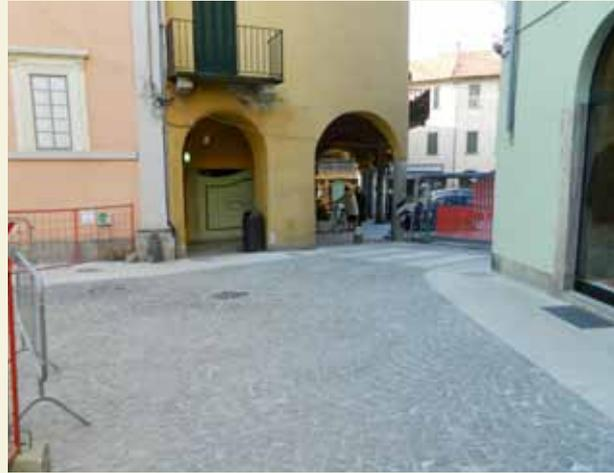
il rifacimento dei sottoservizi e la pavimentazione in porfido e lastre di serizzo.
